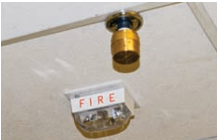
An der Decke angebrachte Löschmittel-düse und Alarmvorrichtung.
